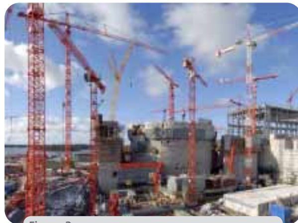
Figura 3 Fasi iniziali della costruzione della centrale di Olkiluoto in Finlandia Fonte: immagine tratta da Internet
