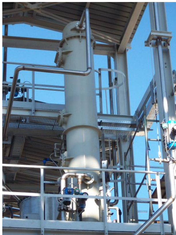
Figura 2.3. Colonna di desolforazione a freddo del syngas.
