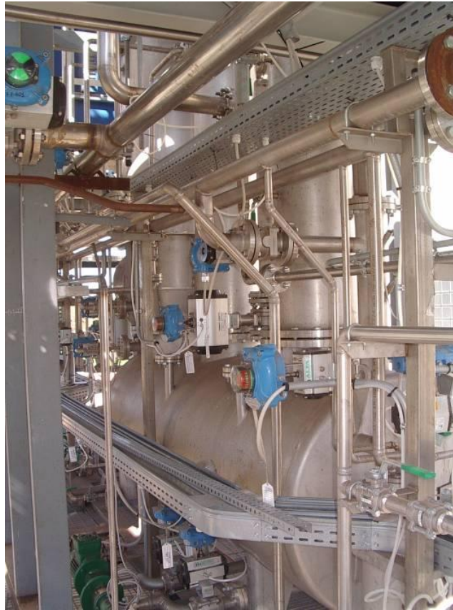
Figura 2.2. Sistema di lavaggio del syngas.
