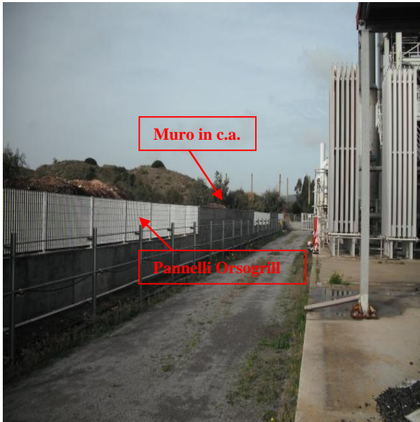
Figura 10 . Recinzione perimetrale impianti
